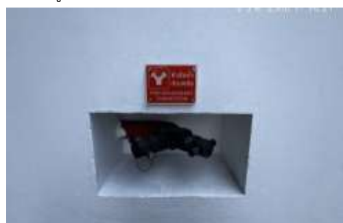
หัวรับน้ำดับเพลิงอาคาร A และ B และท่ออื่น
