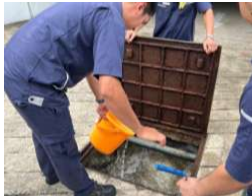
ภาพที่ 2.2-33 เจ้าหน้าที่ตรวจสอบและขุดลอกตะกอนในบ่อหน่วงน้ำ
