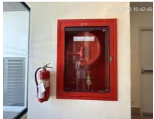
ตู้เก็บสายดับเพลิงถังดับเพลิงแบบมือถือ
