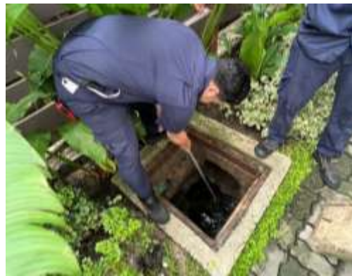
ภาพที่ 2.2-33 เจ้าหน้าที่ตรวจสอบและขุดลอกตะกอนในบ่อหน่วงน้ำ
