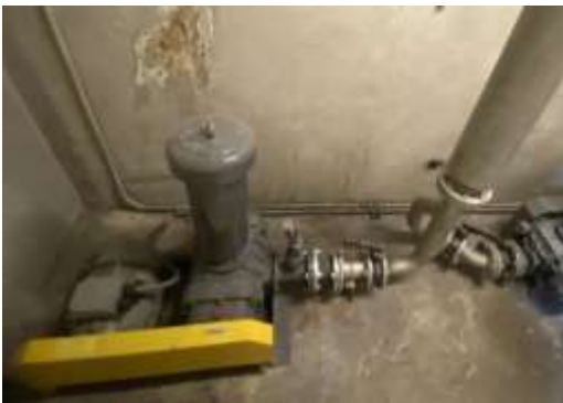
เครื่องเติมอากาศอาคาร A
