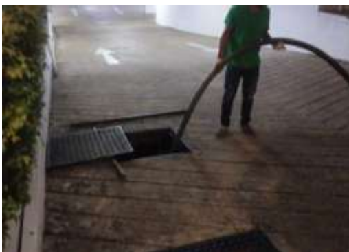
เจ้าหน้าที่สูบน้ำตะกอนในระบบบำบัดน้ำเสีย
